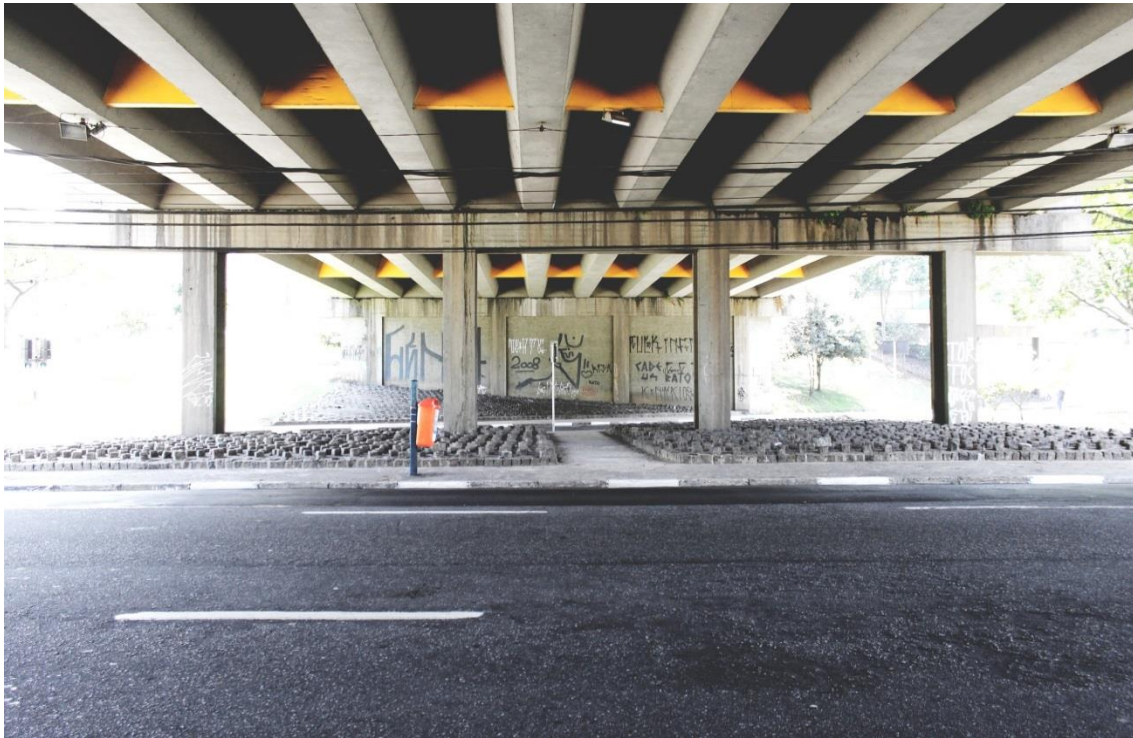
Figura 1. Sob viaduto Kenzo Uemura, São Bernardo do Campo. Fonte: Autoria Própria
