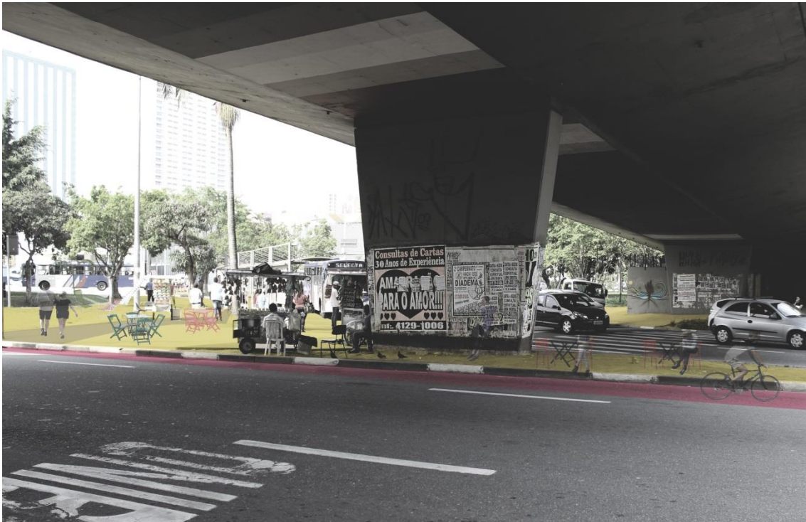
Figura 5. Viaduto. Fonte: Autoria Própria
