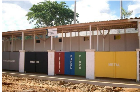
Figura 2. Ponto de Coleta Seletiva em uma Obra.
