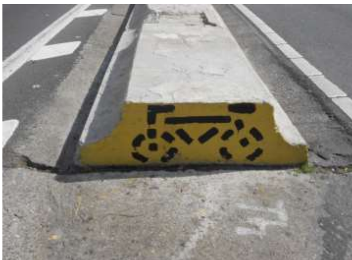
Figura 1: Sinalização de bicicleta no Minhocão
