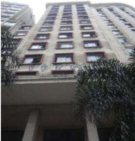
Figura 7 Fachada do Hotel Cambridge Fotografia de autoria própria
