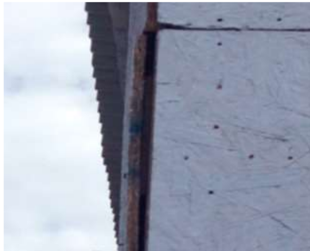
Figura 6. Vão entre os painéis na casa da comunidade Anita.
