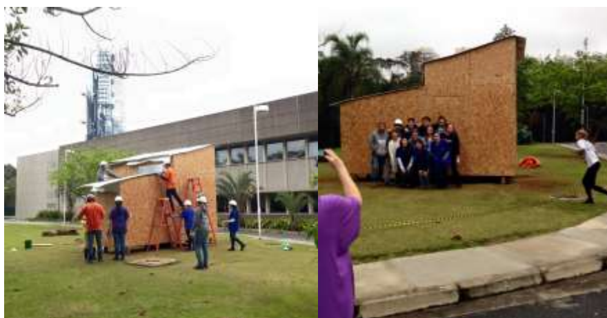
Figuras 13 e 14. Montagem do telhado e protótipo finalizado.
