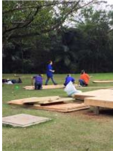
Figura 10. Colocação do piso e separação do material.
