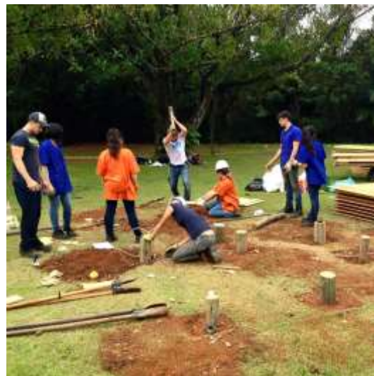
Figura 9. Locação dos Pilotis.
