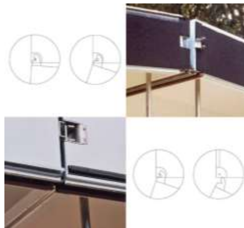
Figura 17– Detalhe do sistema de grampos de tensão que anexam os módulos. Fonte: http://www.krill.nl/en/gardenhouse-meister/
