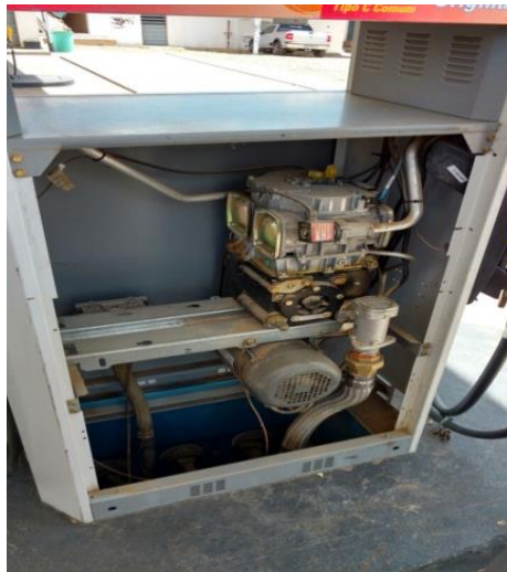
Figura 9: Bomba de Abastecimento
