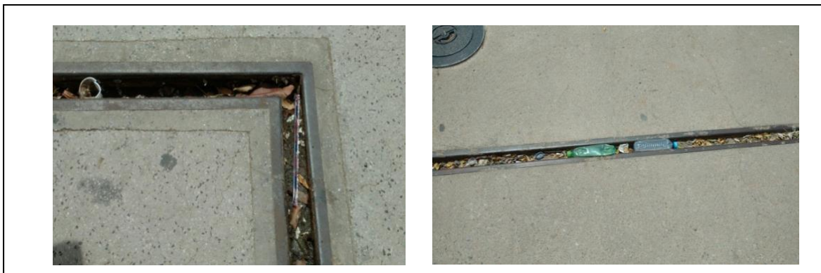
Figura 10: Canaletas Fonte: Própia
