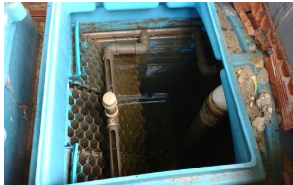
Figura 8: Caixa Separadora de água e óleo
