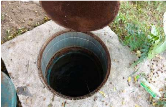
Figura 6: Caixa Coletora
