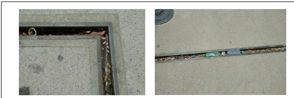
Figura 10: Canaletas Fonte: Própia
