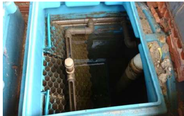
Figura 8: Caixa Separadora de água e óleo
