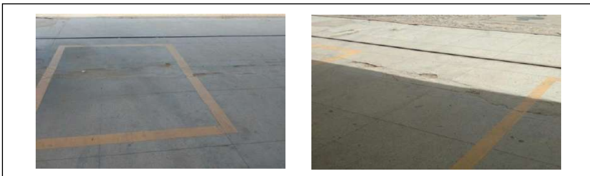
igura 3: Piso Impermeável
