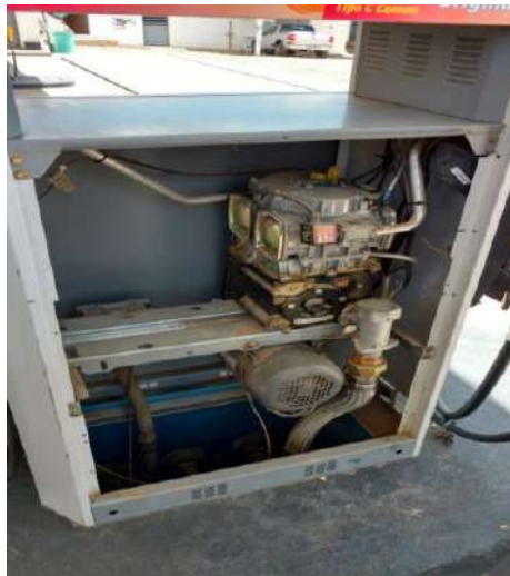
Figura 9: Bomba de Abastecimento
