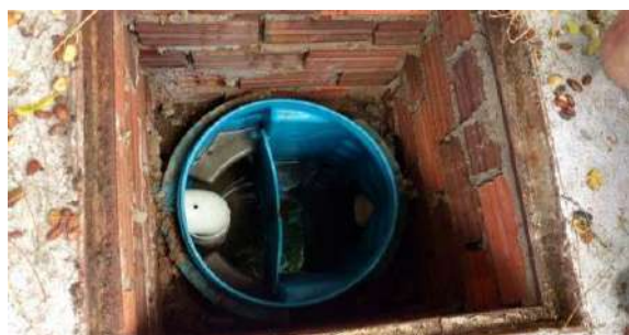
Figura 4: Tanque Subterrâneo
