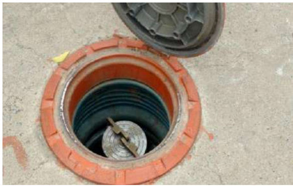
Figura 7: Caixa Coletora
