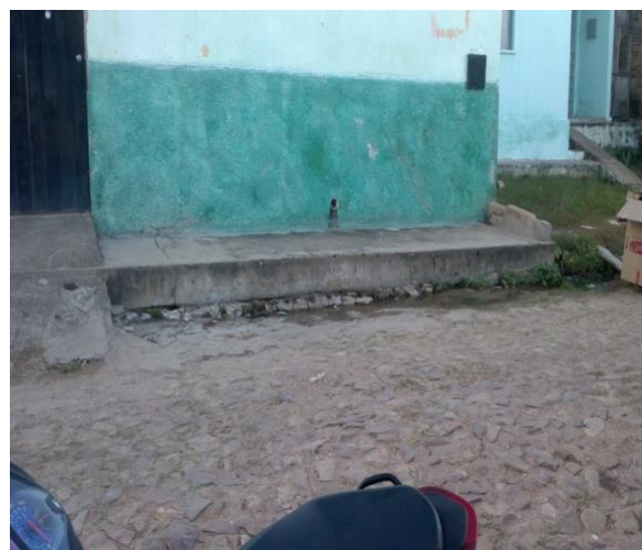
Figura 14 – Situação das ruas do bairro
