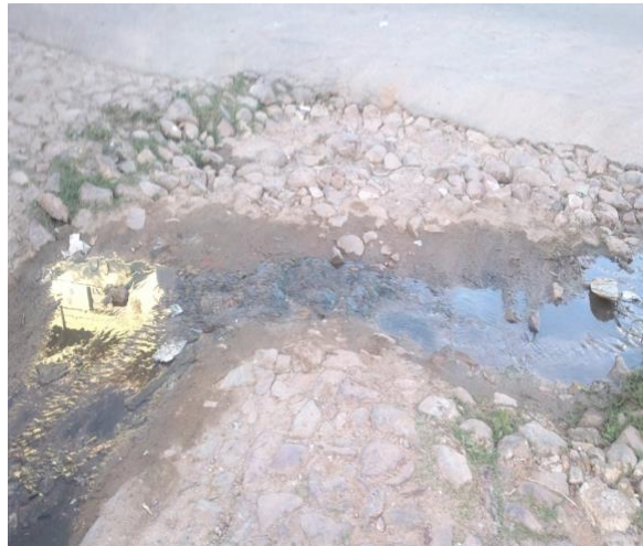
Figura 15 – Esgoto a céu aberto
