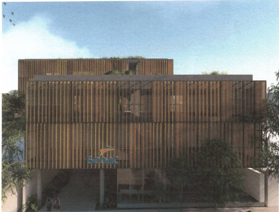
Vista do novo edifício mostrando a configuração volumétrica, com a diversidade de gabaritos e aberturas dos pátios e jardins
