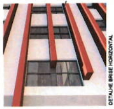
DETALHE BRISE VERTICAL
